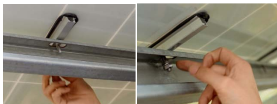
图2 易安得新挂钩安装简化
